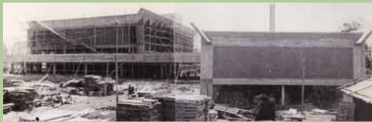
八代市厚生会館完成間近の様子
