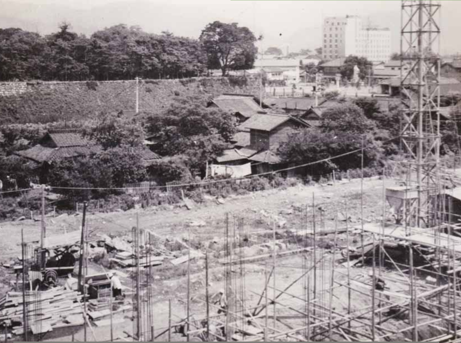
会館建築中の風景。八代宮のお堀との間にある道路には、かつて民家が並び、その向こうには太洋デパートが確認できます。
